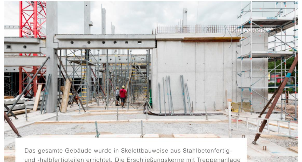
Das gesamte Gebäude wurde in Skelettbauweise aus Stahlbetonfertig- und -halbfertigteilen errichtet. Die Erschließungskerne mit Treppenanlage und Aufzugsschacht wurden als herkömmlicher Massivbau in Stahlbeton ausgeführt. Inklusive Treppen und Podesten wurden rund 255 Fertigteile verbaut. Fertigteilstützen mit 14 m Länge wurden teils in über 5 m hohe Hohlwände und Treppenhauswände in Ortbeton eingebunden.
