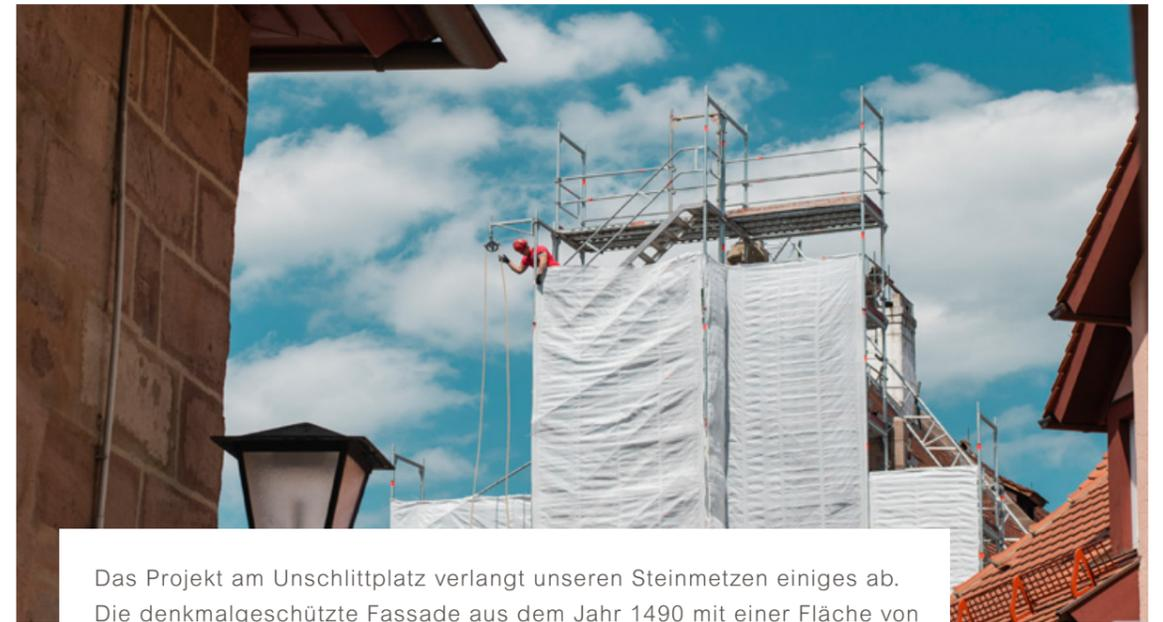
Das Projekt am Unschlittplatz verlangt unseren Steinmetzen einiges ab. Die denkmalgeschützte Fassade aus dem Jahr 1490 mit einer Fläche von 1.900 m<sup>2</sup> und 3.500 m Fugen wird komplett restauratorisch überarbeitet, d. h. gereinigt, zahlreiche Steine ausgetauscht und profilierte Neuteile eingebaut.
