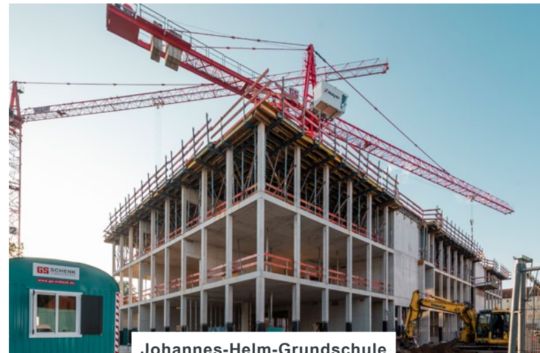
Johannes-Helm-Grundschule Ersatzneubau mit Turnhalle
