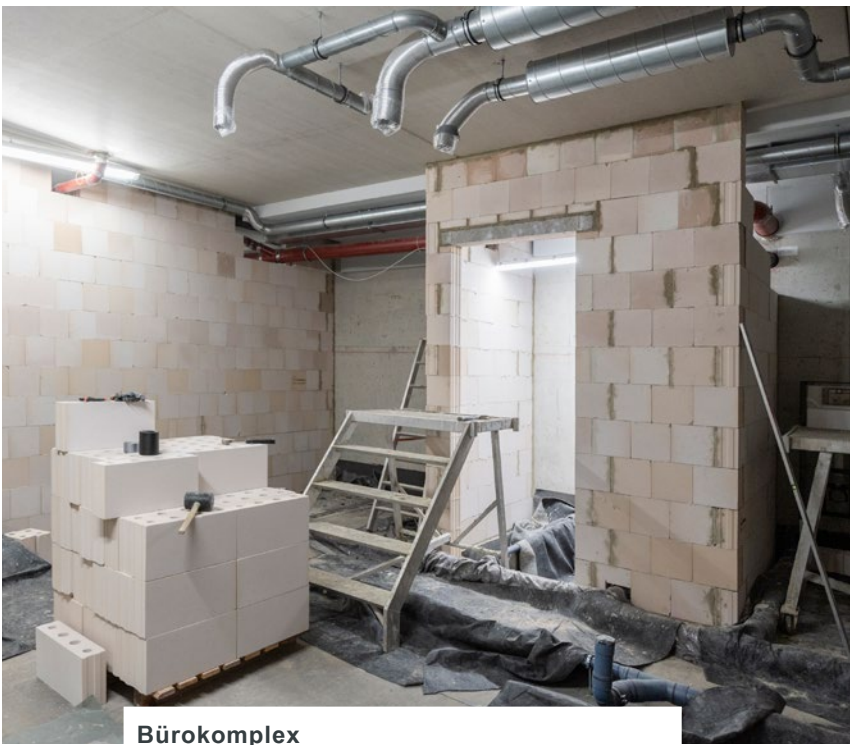
Bürokomplex Trennwände & Ummauerung Lüftungsanlagen
