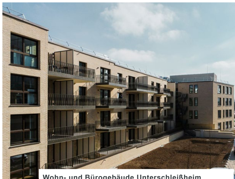
Wohn- und Bürogebäude Unterschleißheim 59 Wohnungen, Tiefgarage, öffentliche Zufahrtsstraße
