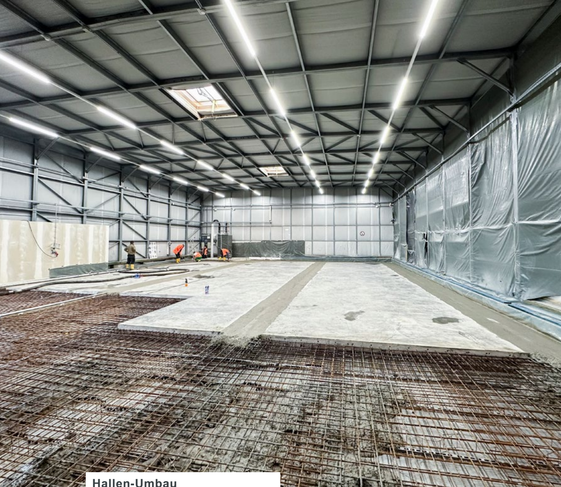
Hallen-Umbau Vom Lager zur Produktionshalle
