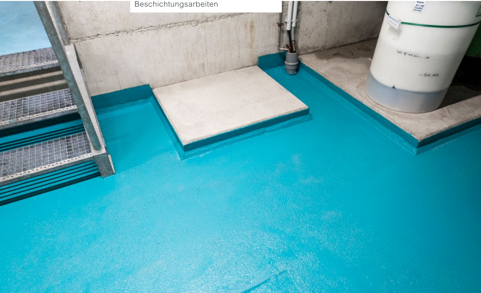
Langwasser Bad Beschichtungsarbeiten
